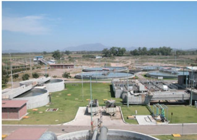
Opera a través de un sistema primario avanzado. Cubre el saneamiento del 83% del agua residual generada en la ciudad de Culiacán. El arranque fue el 15 de Enero de 2002, diseñada para un caudal medio de 1,700 litros por segundo y máximos de hasta 2,550 litros por segundo.
